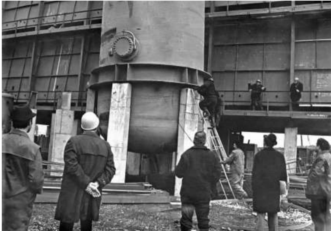
На втором агрегате аммиака устанавливают аппарат Н-1
