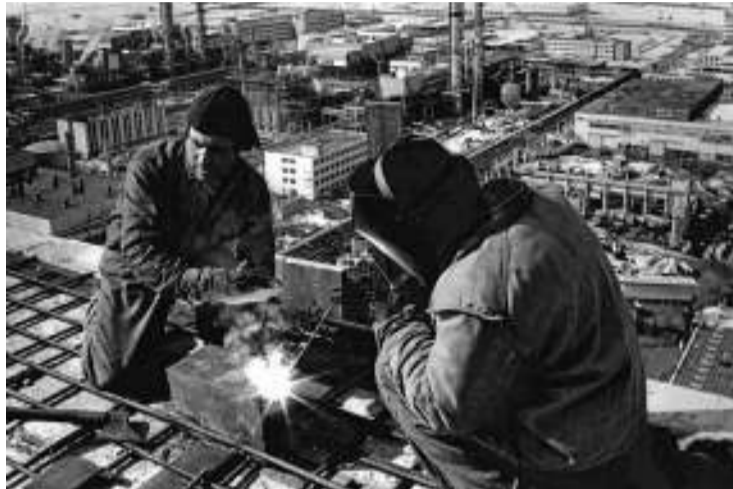
Монтажники на грануляционной башне производства карбамида
